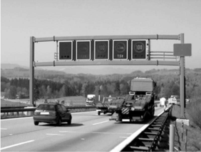
*Bild 5: Schilderbrücke einer Streckenbeeinflussungsanlage (ABD Südbayern)*
