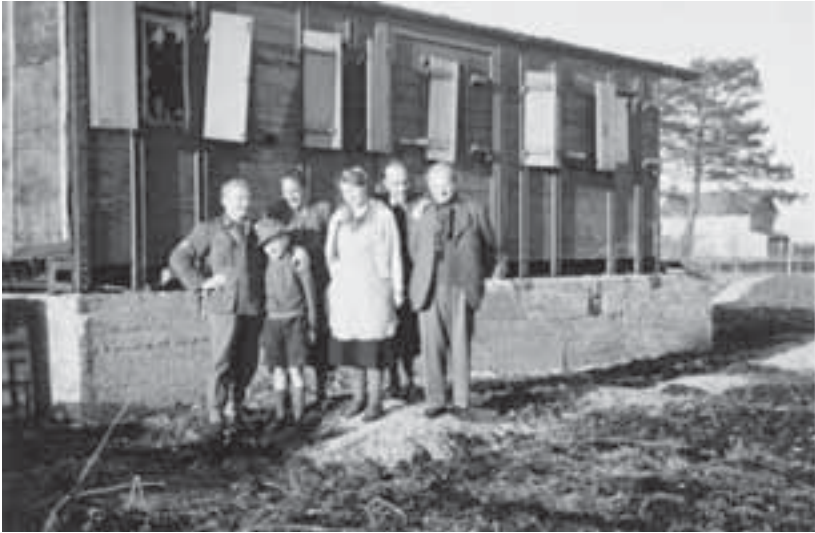
Hauptsache ein Dach über dem Kopf! Nachkriegssiedlung in Karlsfeld.
